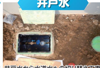
井戸水から水道水への切り替え工事
