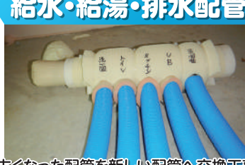
古くなった配管を新しい配管へ交換工事
