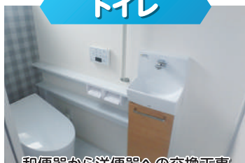
和便器から洋便器への交換工事
